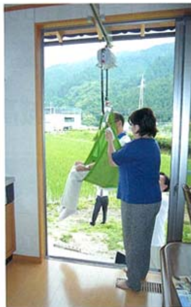
「手すりの会」の会員が試してみる・・・スリング（吊り具）に乗ったまま 外壁から持ち出しの走行レールで、南のはき出しから外に出ているところ（平行移動は手動で行う）
