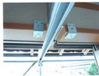
リフトが通る時の状態 着脱式の窓枠はとっているところ
