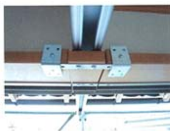
普段の南のはき出しの窓枠の状態 サッシ戸がスムーズに動くために 着脱式の窓枠をはめている
